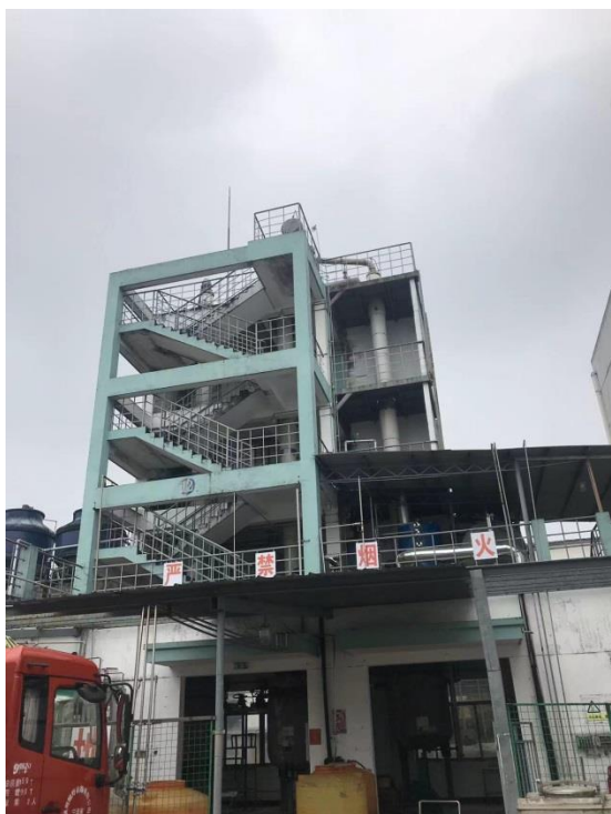
乙醇回收单元及乙醇废气吸收罐
