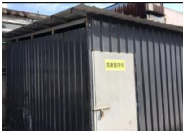
危废暂存间（外）
